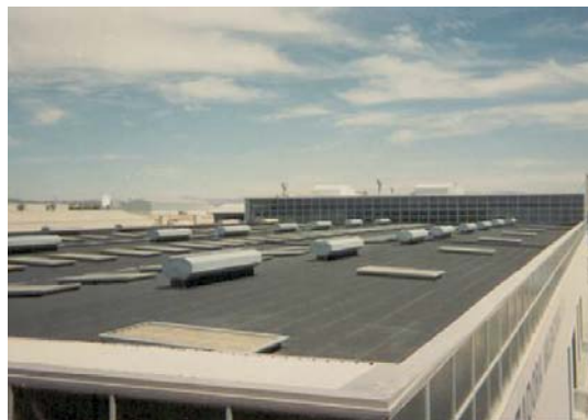
Situación incorrecta. Falta protección perimetral de borde.
