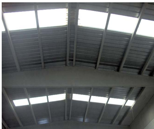
Situación incorrecta. Falta protección perimetral de borde.
